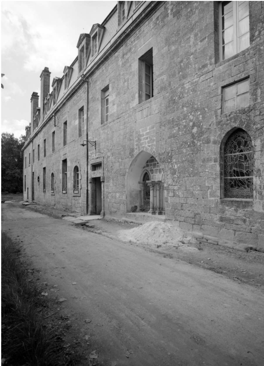
Corps de bâtiment D, façade est, partie centrale prise du nord-est (1965)
