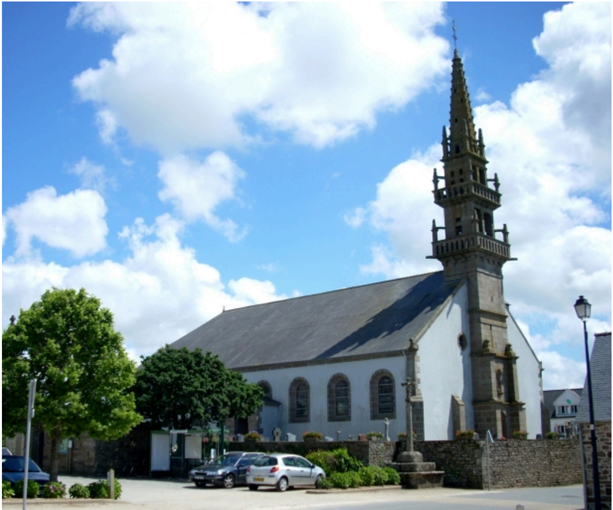
Ploumoguier, église paroissiale : vue générale nord-ouest
