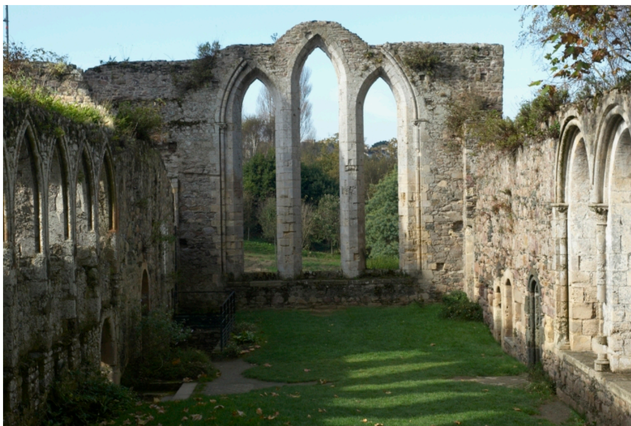
Vue vers le pignon ouest du réfectoire
