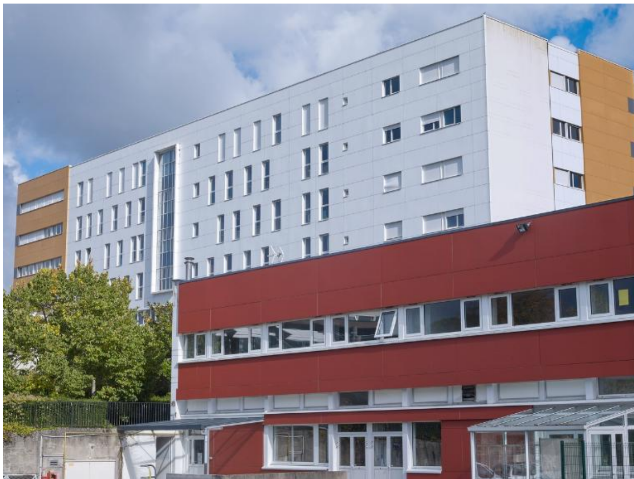
Bâtiment B (internat, logements, classes) et, au premier plan, bâtiment C (restauration, infirmerie, foyer), façades ouest. André Remondet et Patrice Simon, architectes, 1966.
