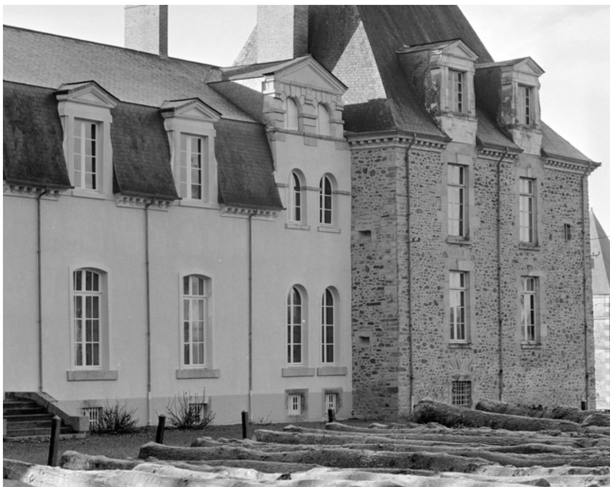
Elévation nord, détail.
