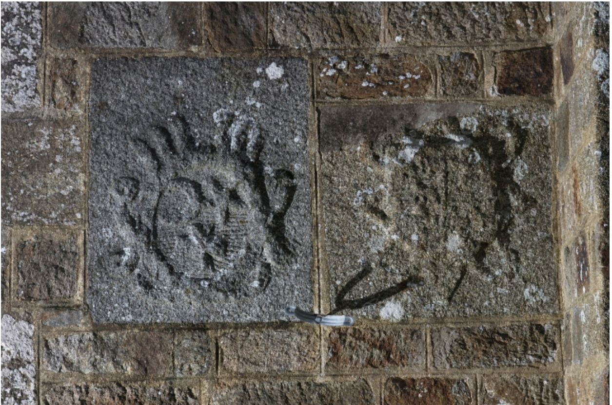
Elévation occidentale de l'église : détail de deux blasons de l'ancienne église
