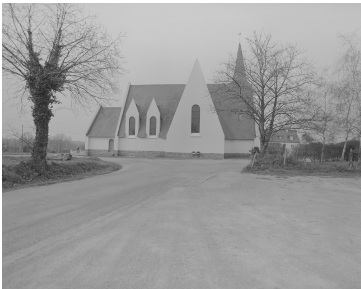
Elévation Ouest : vue générale
