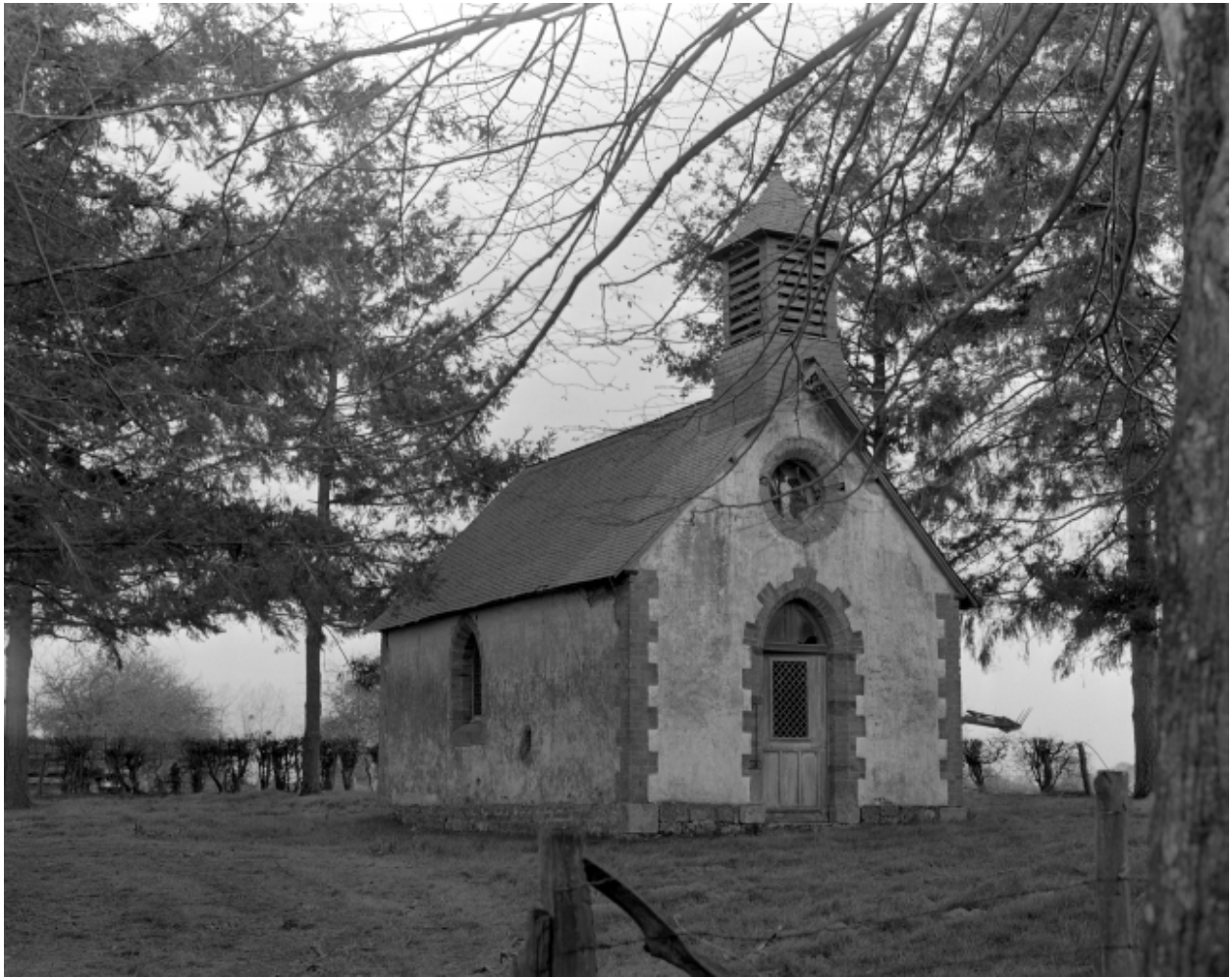
Élévation Nord-Ouest : vue générale
