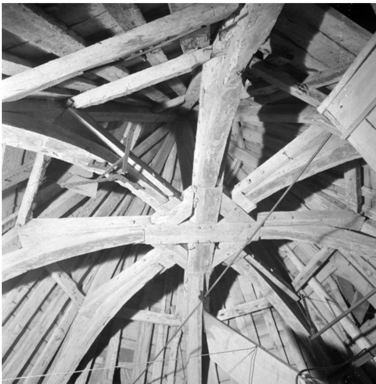
Charpente du clocher, vue de l'escalier.
