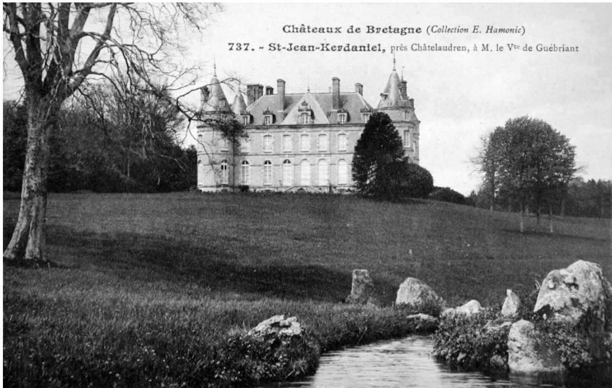
Vue générale de la façade sud
