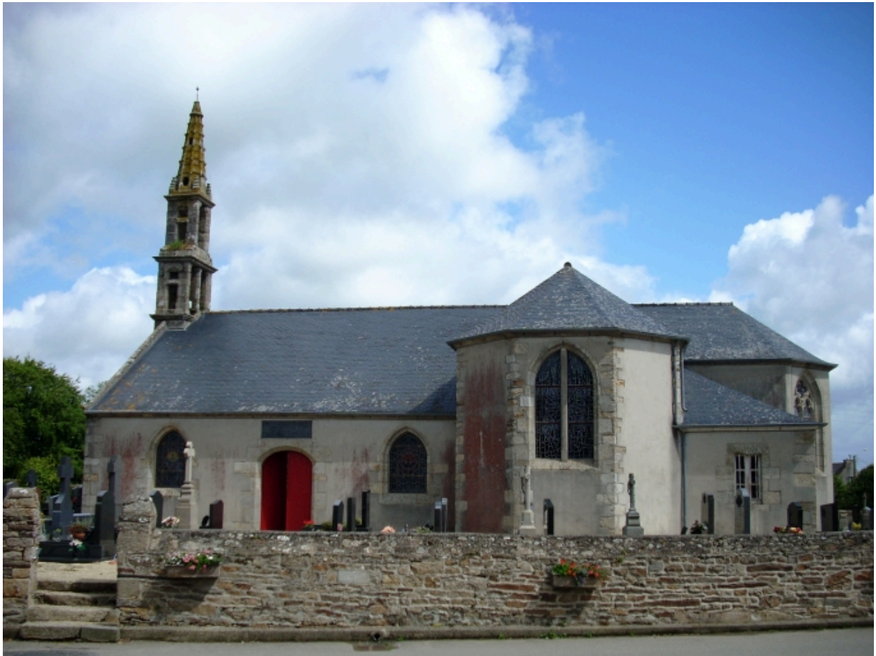
Saint-Derrien, église paroissiale Saint-Derrien : élévation sud
