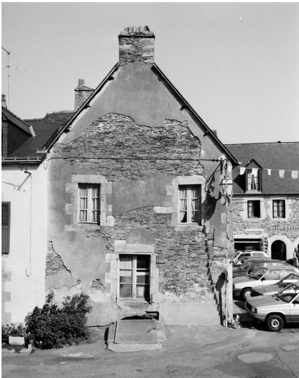
Maison de commerçant : pignon sud (état en 1992)
