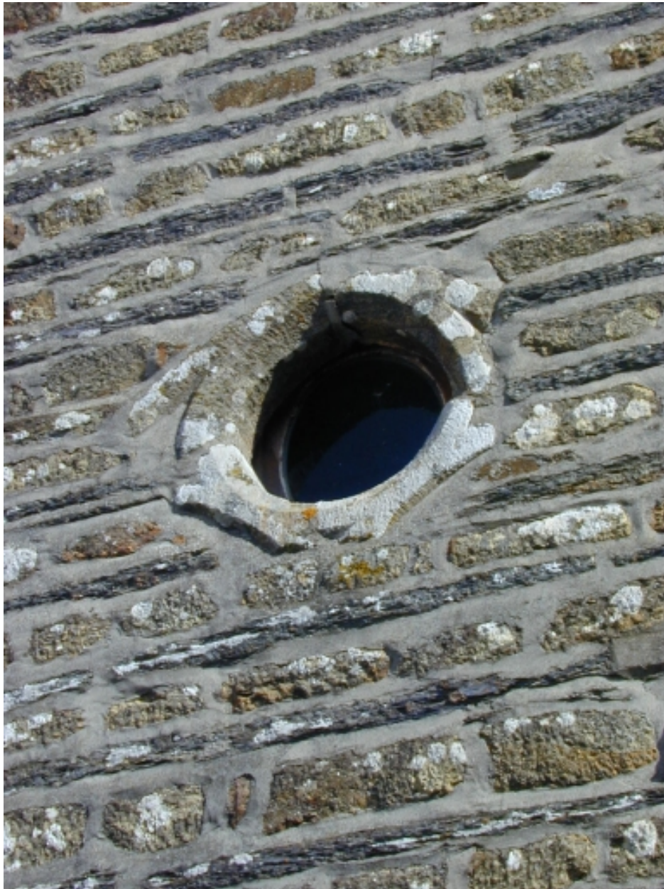
Mur sud, détail, oculus formé de remplois de fenestrages anciens
