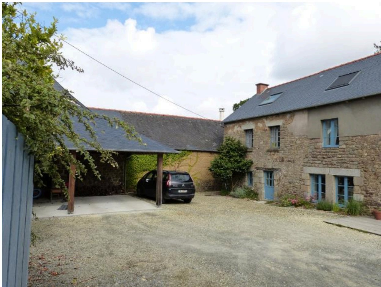
Vue générale sud et est
