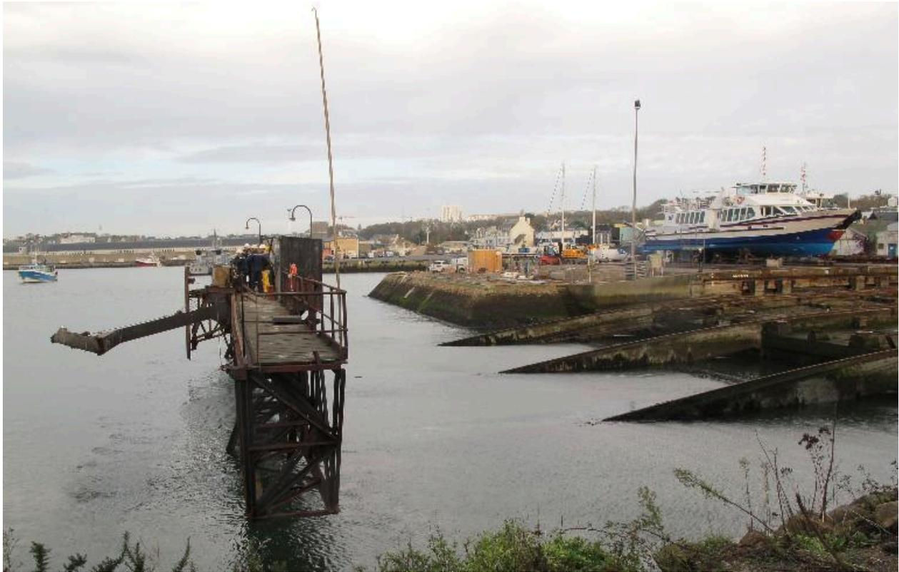
Bateau de pêche en approche ; passerelle en partie basse du slipway ; rampe du slipway
