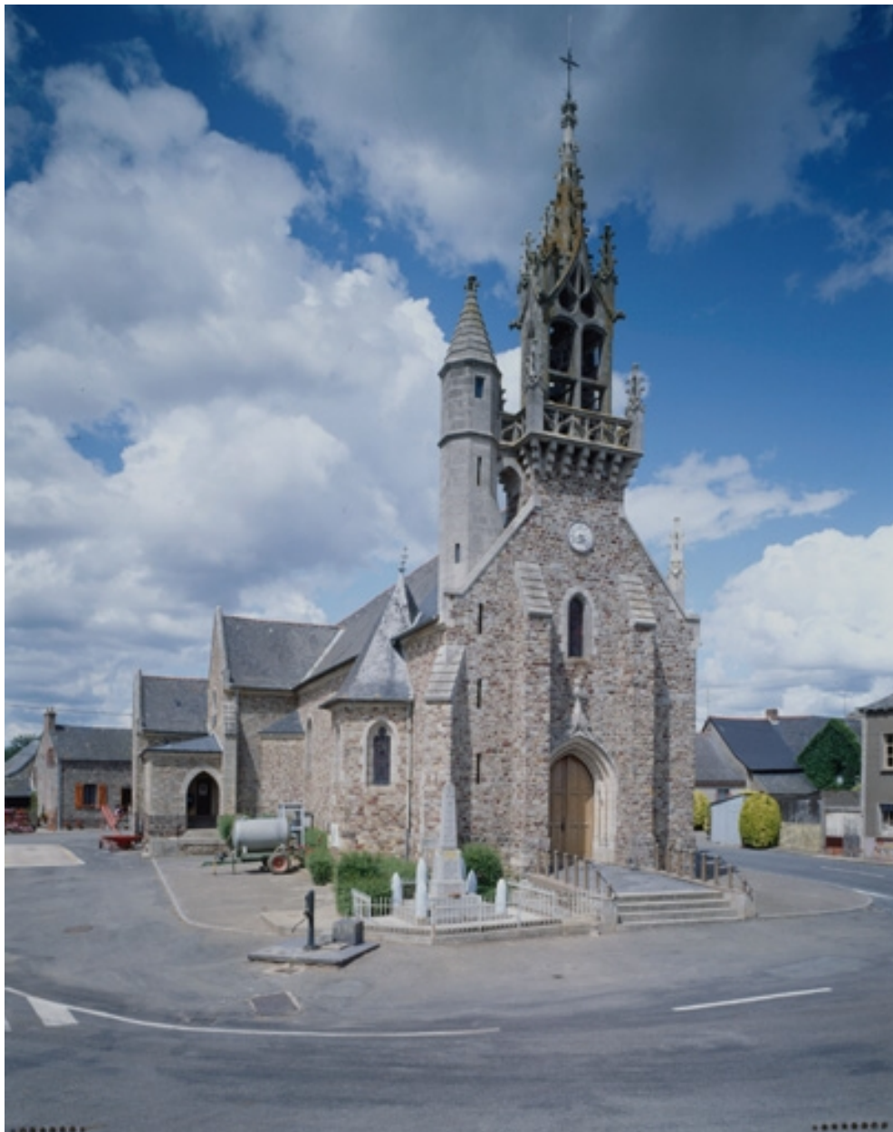
Elévation Ouest : vue générale
