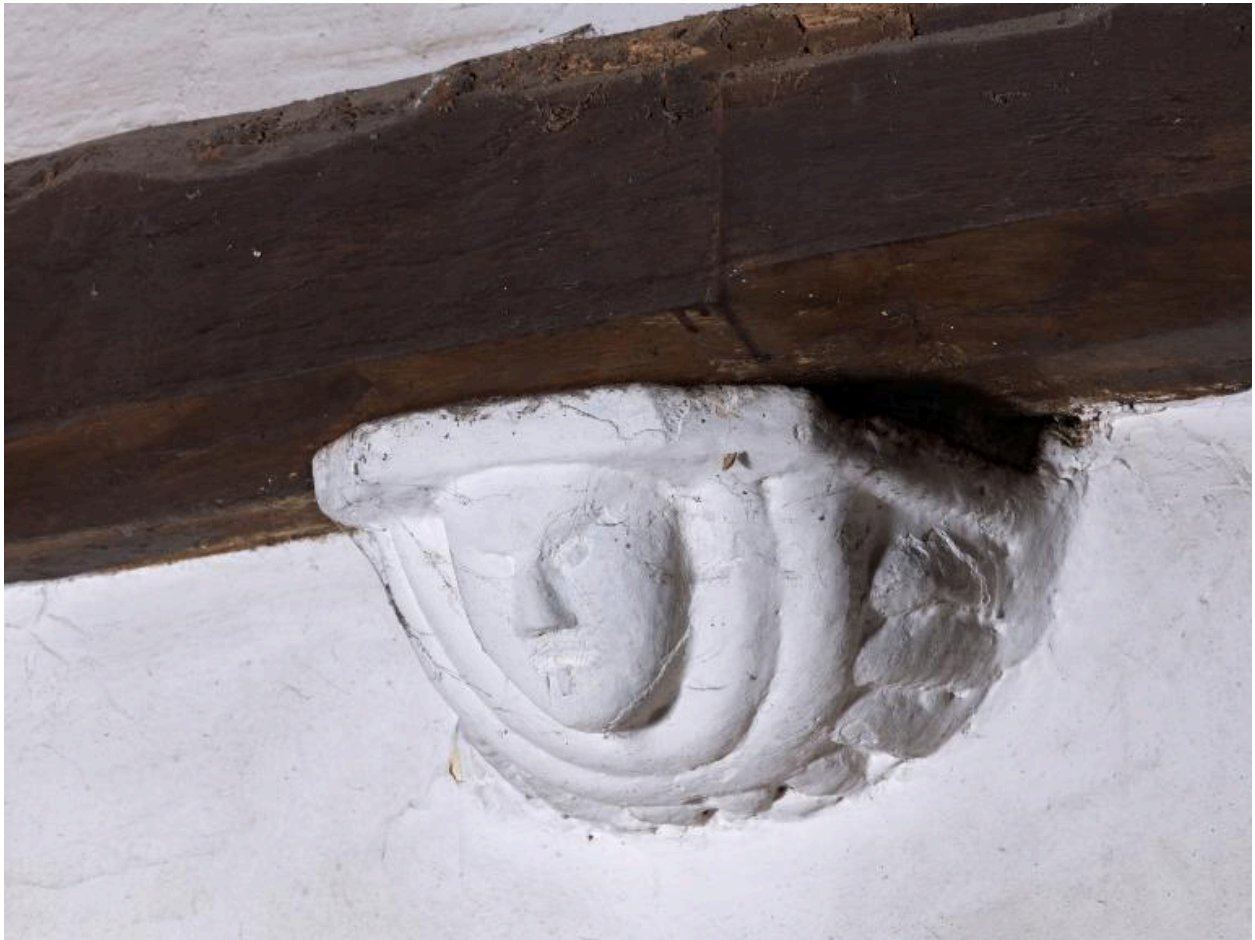
Bras nord du transept : détail culot figuré 2
