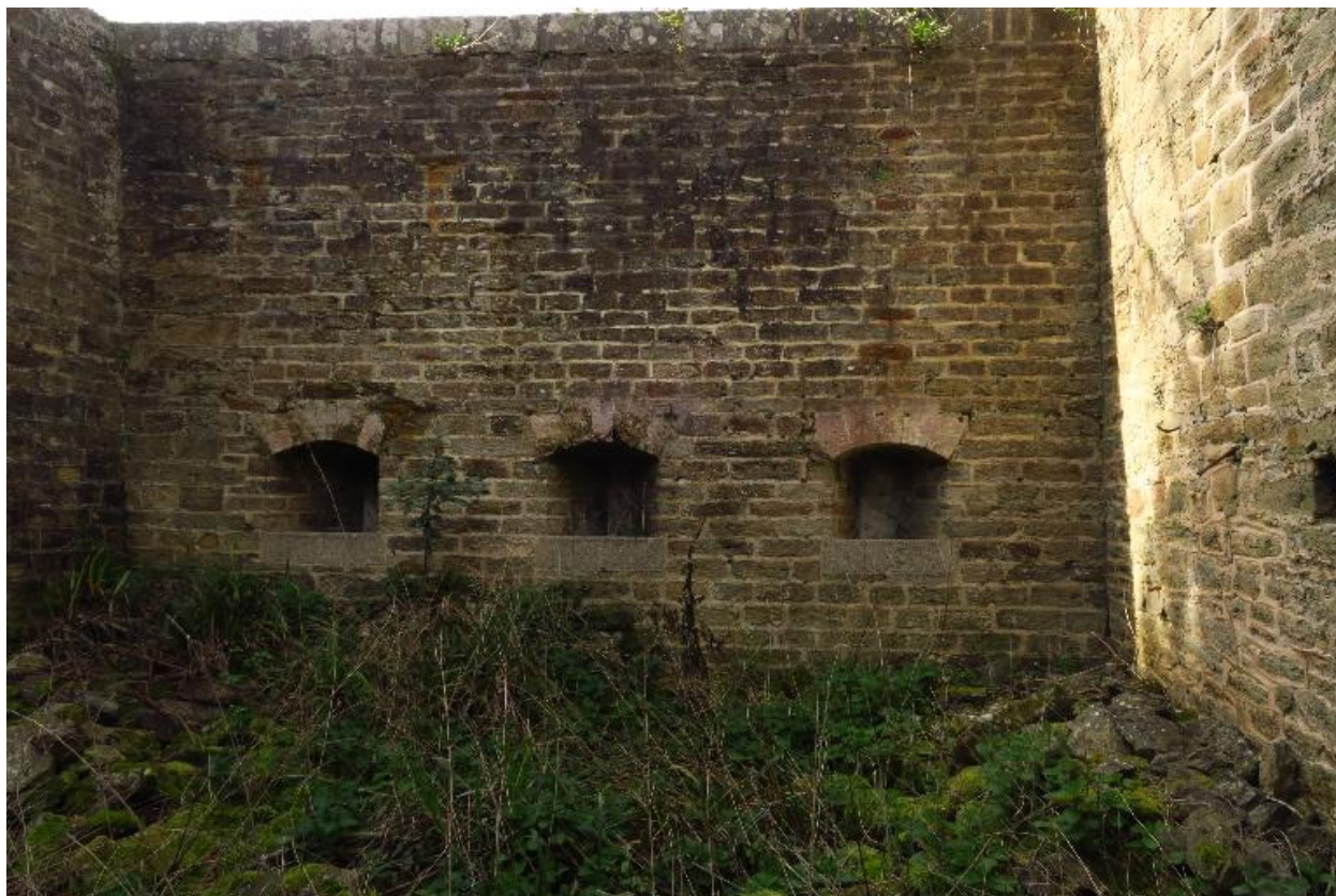
Le Palais, enceinte urbaine, bastion 20, mur crénelé de droite.
