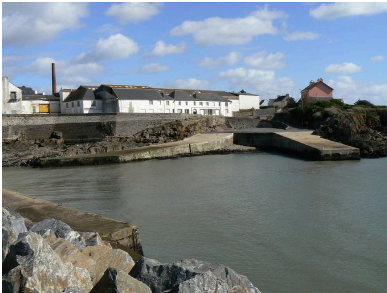
Vue générale de la zone d'activité portuaire industrielle liée à l'ancienne conserverie Capitaine Cook
