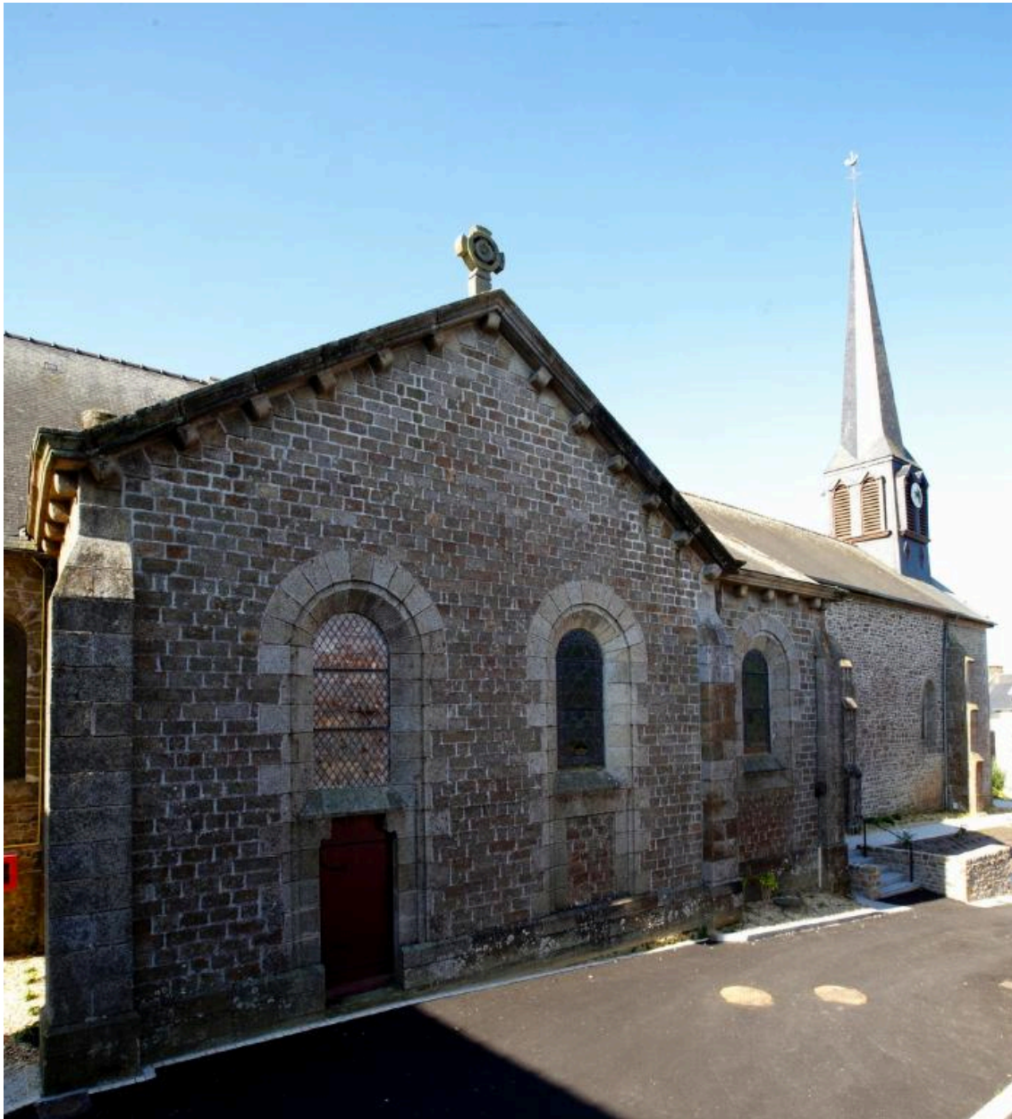
Elévation Nord, bras du transept : vue générale
