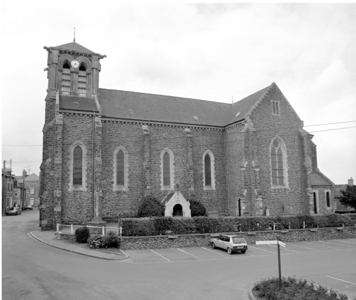
Elévation Sud : vue générale
