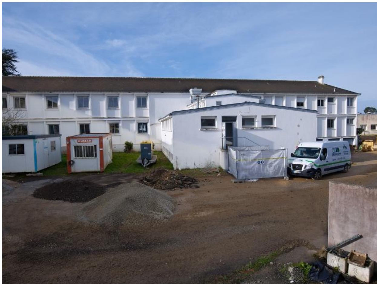
Vue d'ensemble de la façade est des cuisines (au premier plan) et de l'internat. Yves Guillou, architecte, 1962.
