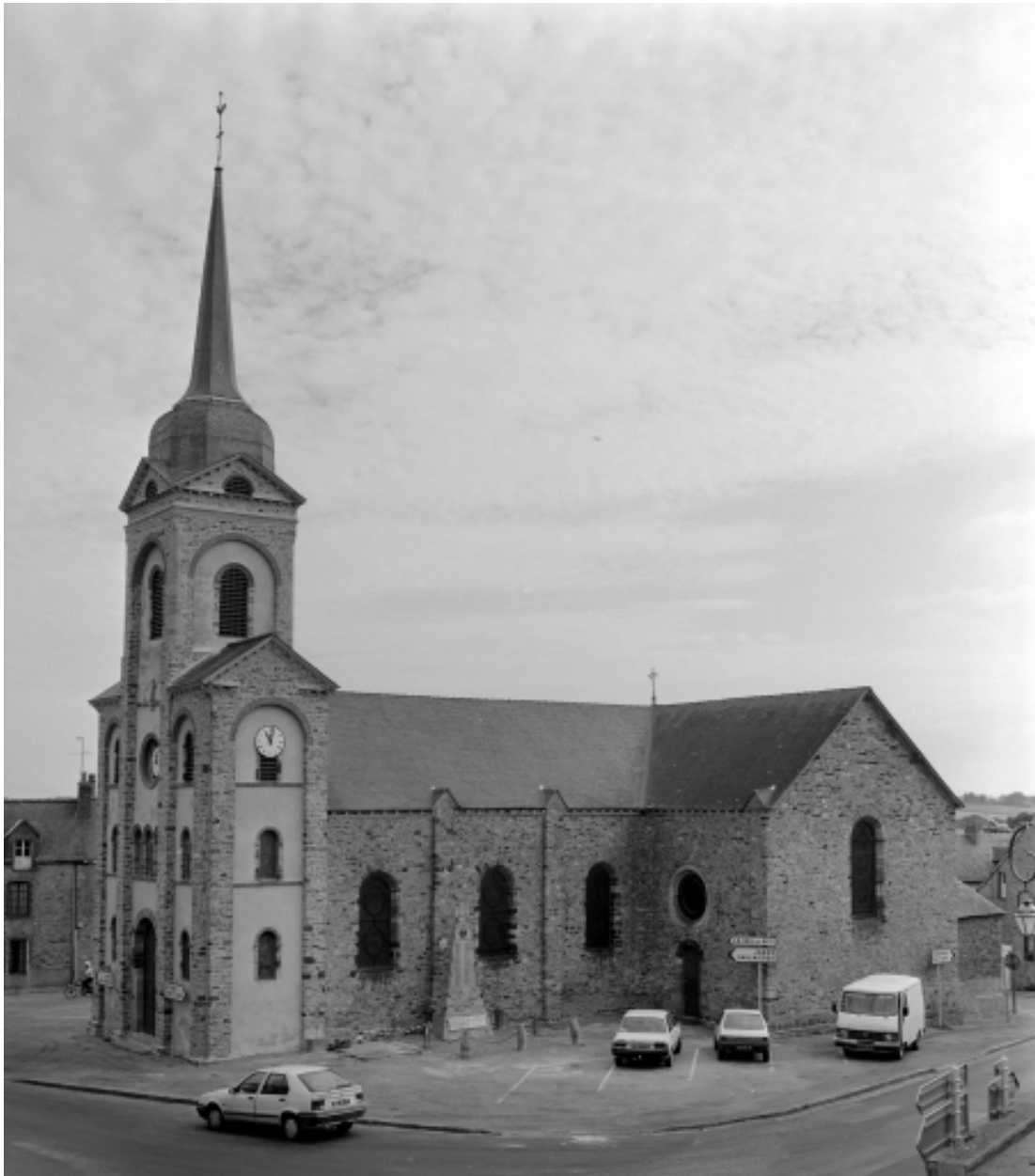
Elévation sud : vue générale
