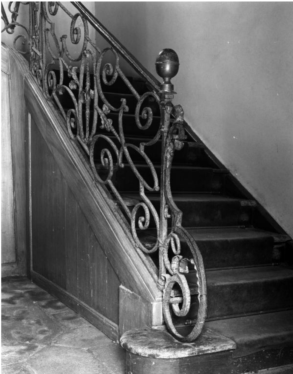
Logis, rez-de-chaussée, rampe d'escalier, détail.
