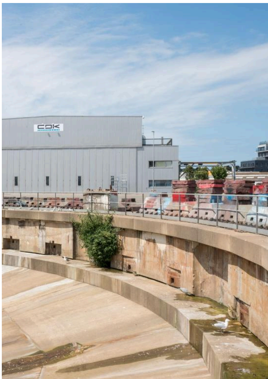
Vue de la fosse du slipway vers le nord
