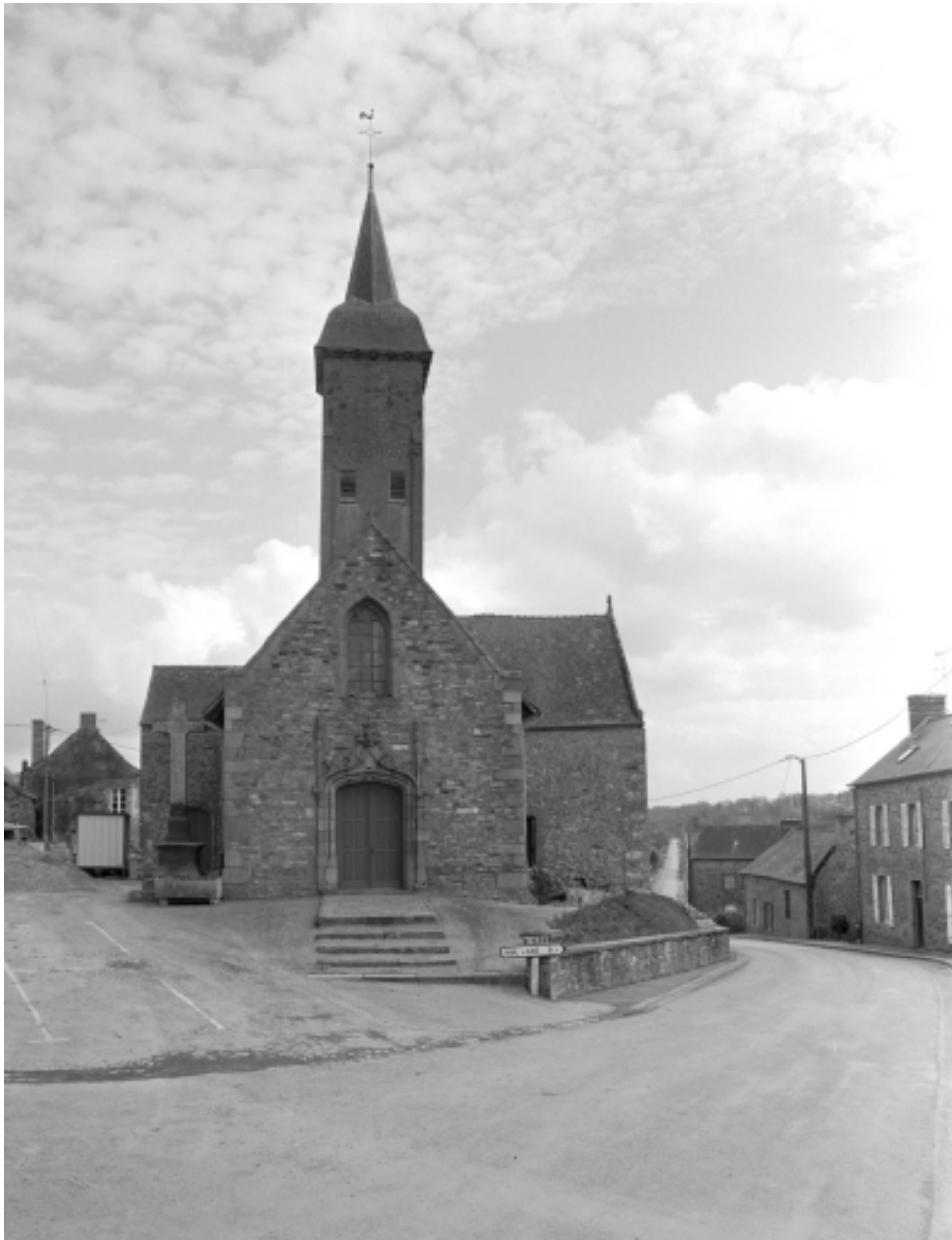
Vue générale de la façade principale
