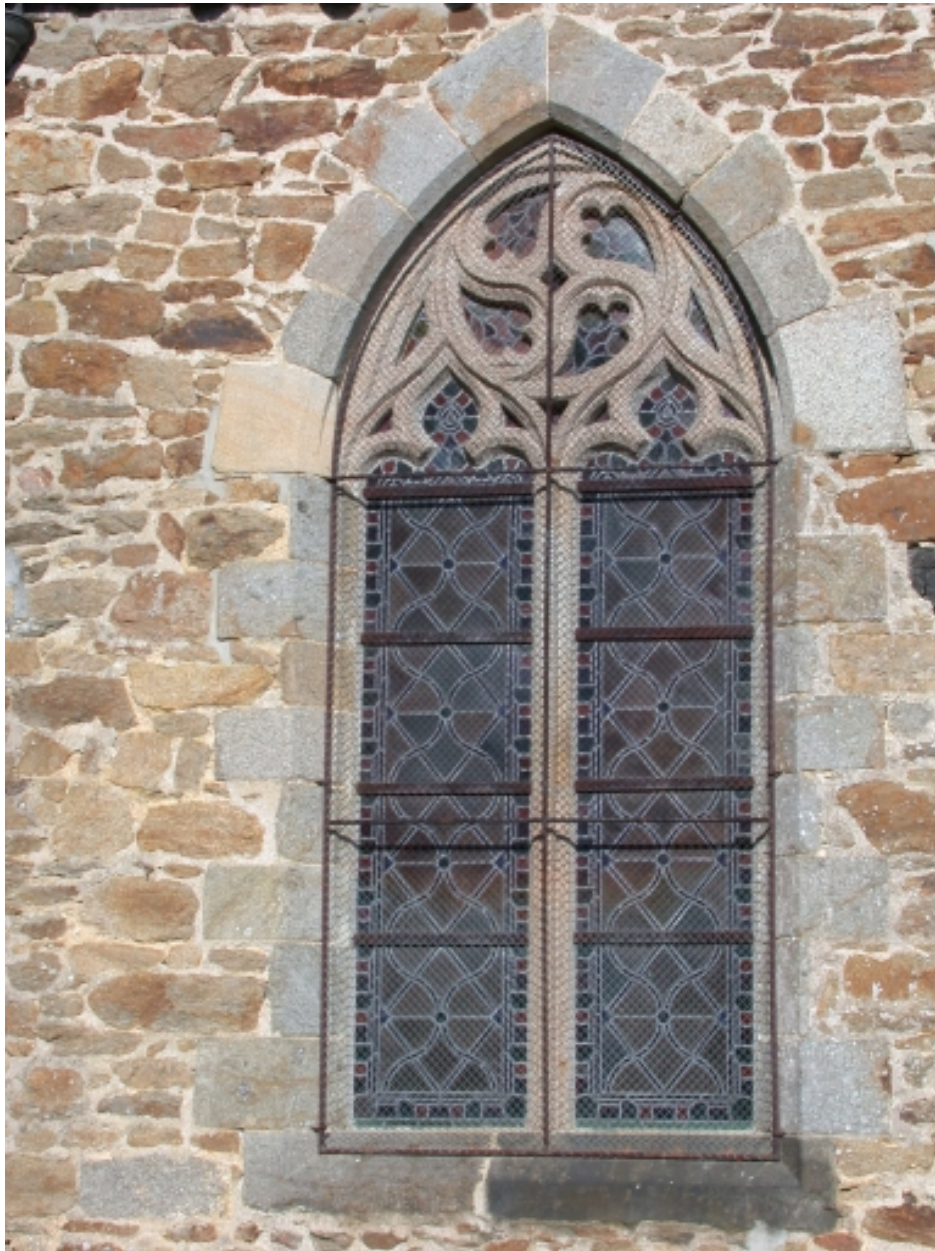
Choeur, mur sud, (baie 2)
