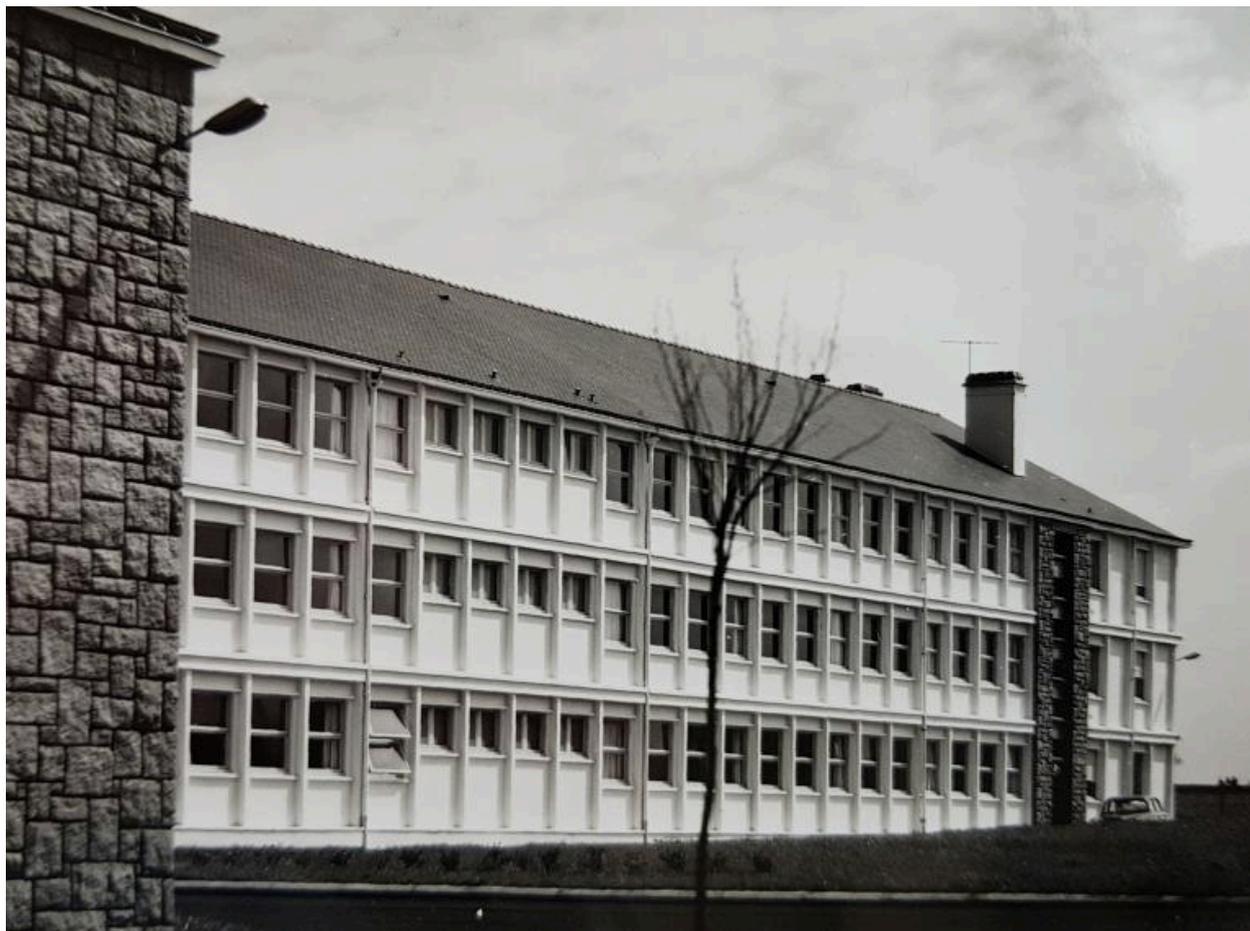
Façade ouest de l'internat (Yves Guillou architecte, photo ca. 1963). Le rationalisme de l'architecture se lit sur la façade : les allèges des blocs sanitaires sont plus hautes que celles des chambres.
