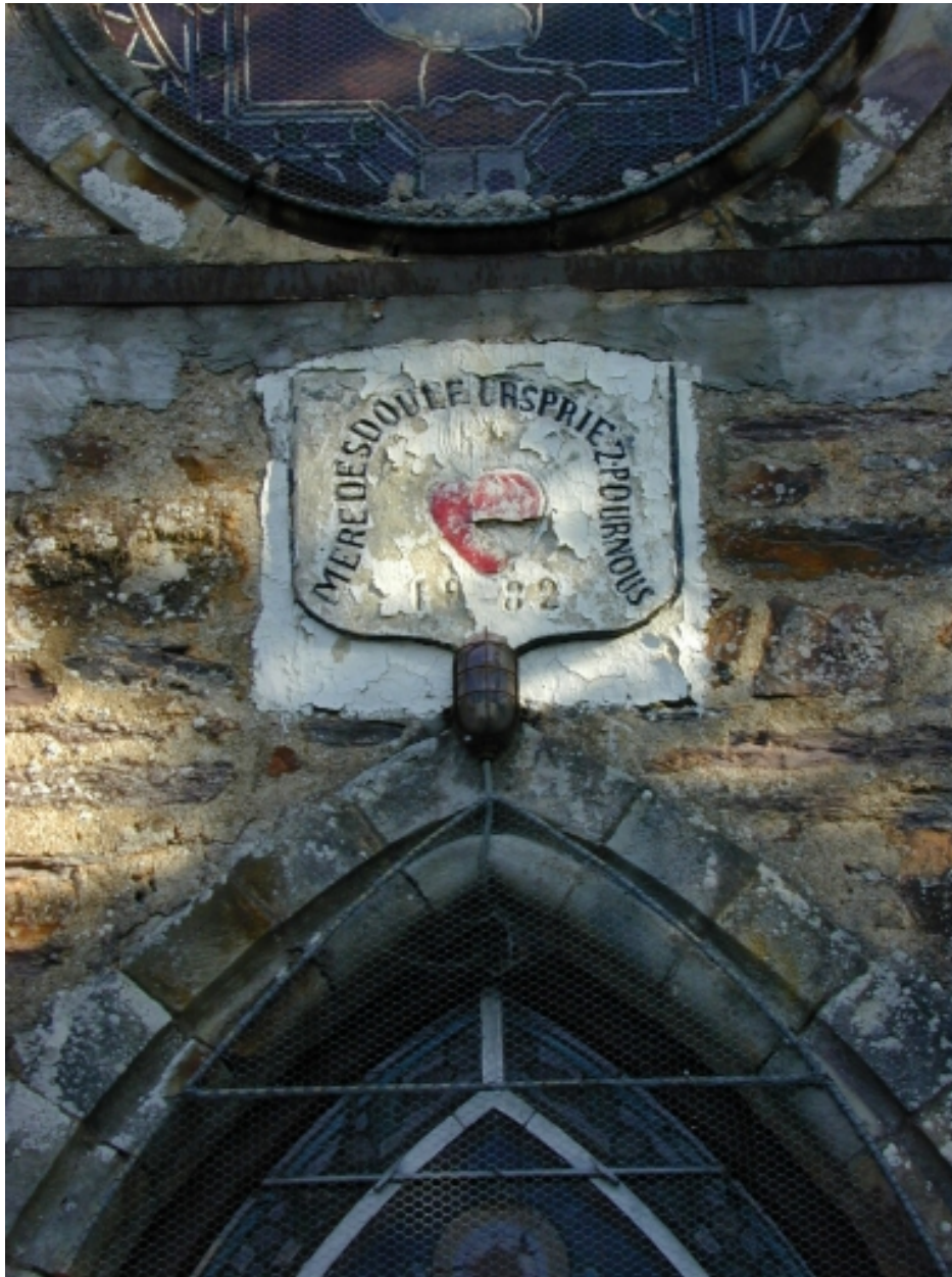
Façade sud, pierre de calcaire portant date et dédicace : détail
