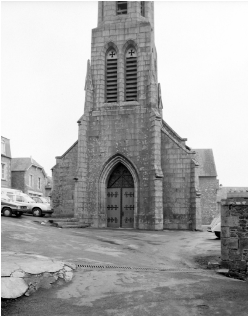
Elévation Ouest : vue générale
