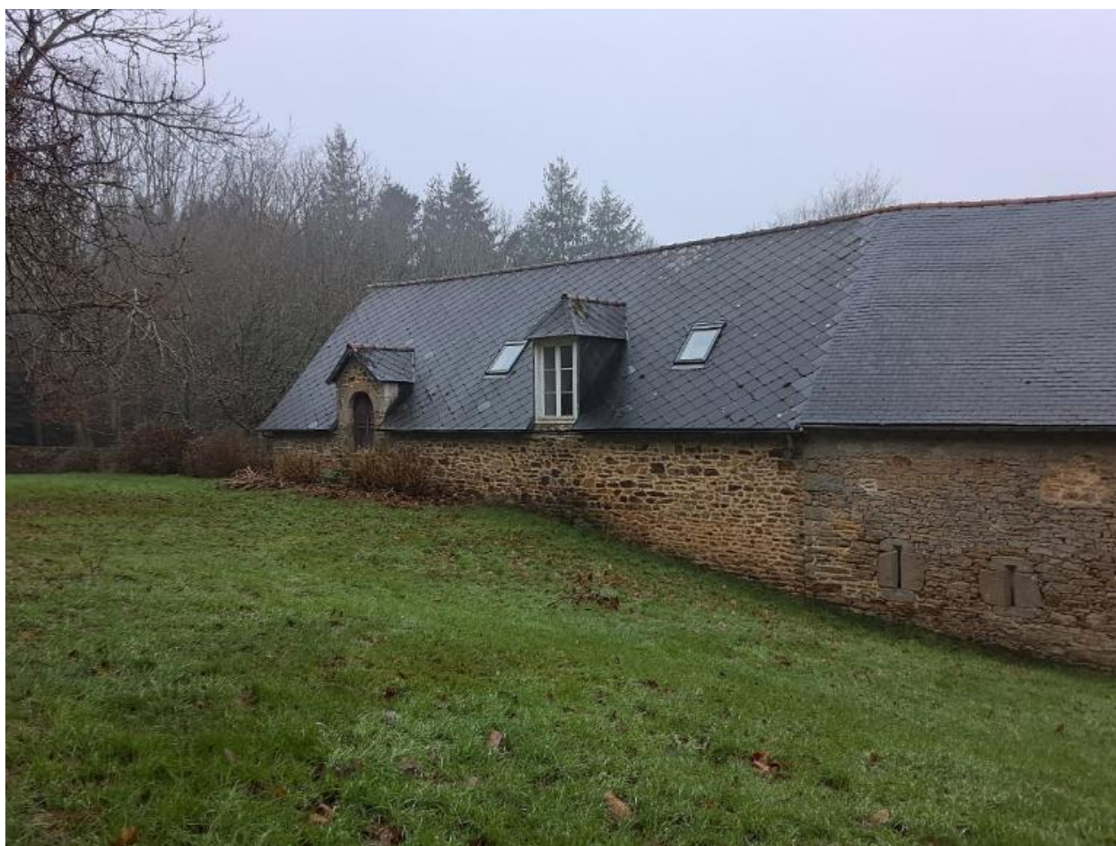
Les dépendances, façade est
