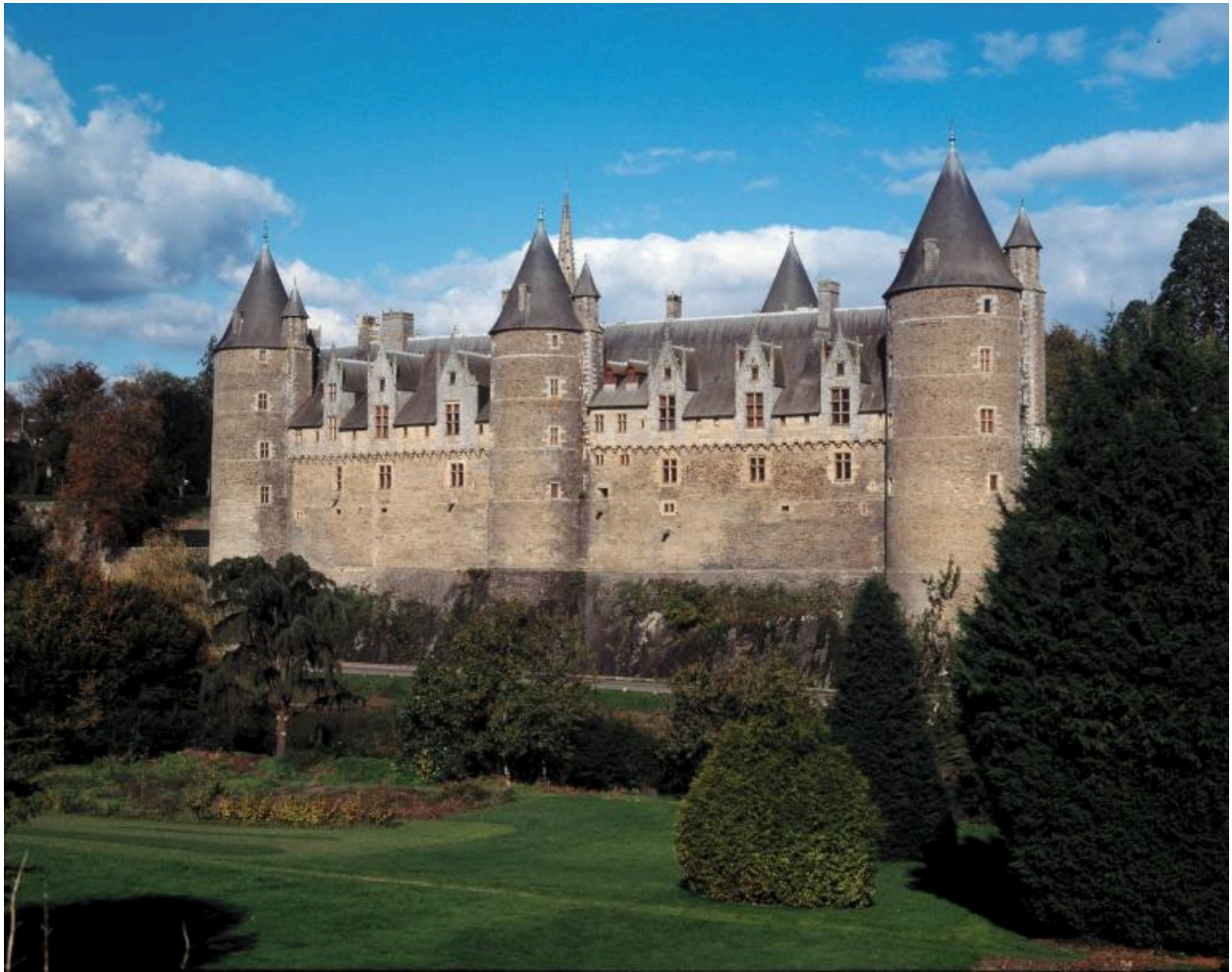
Vue de situation prise du sud
