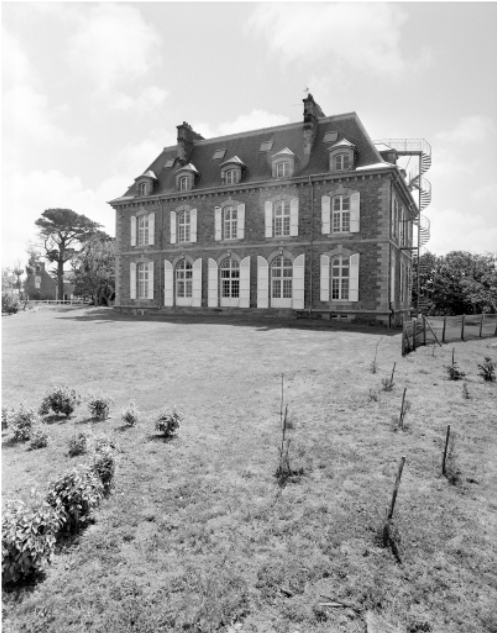
Vue générale de la façade nord-est du château.
