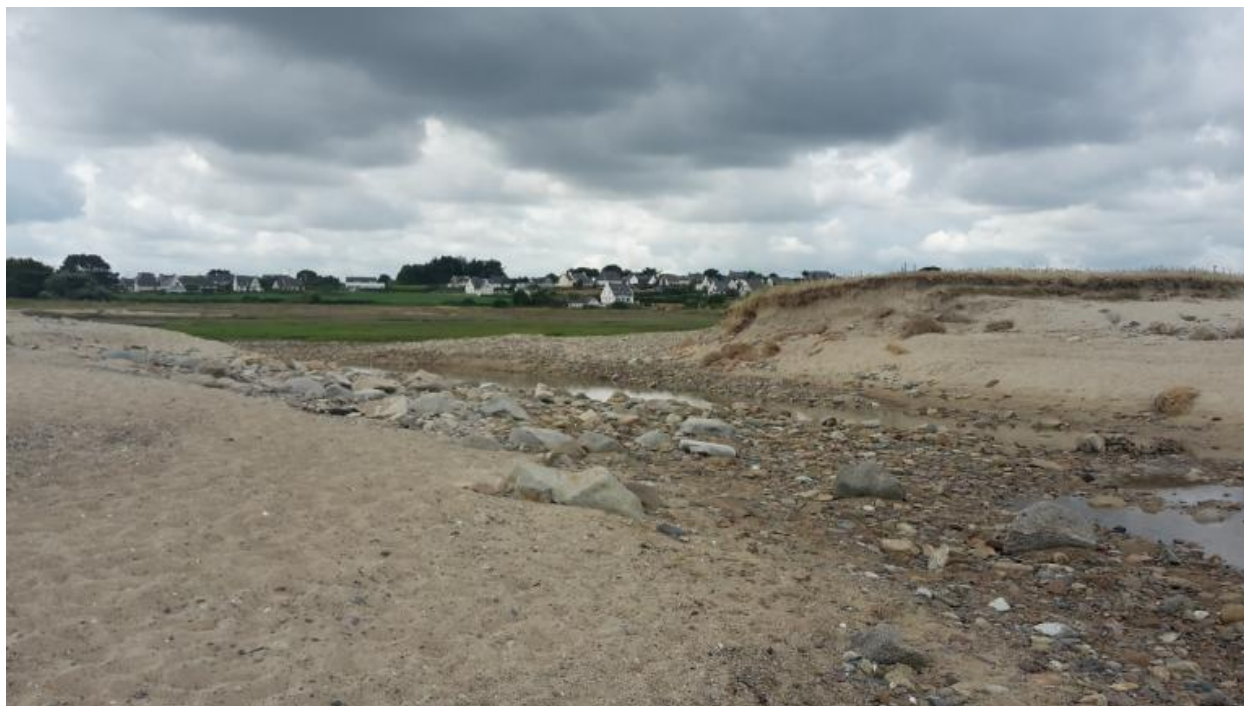
Vue de la brèche du cordon dunaire, 2018
