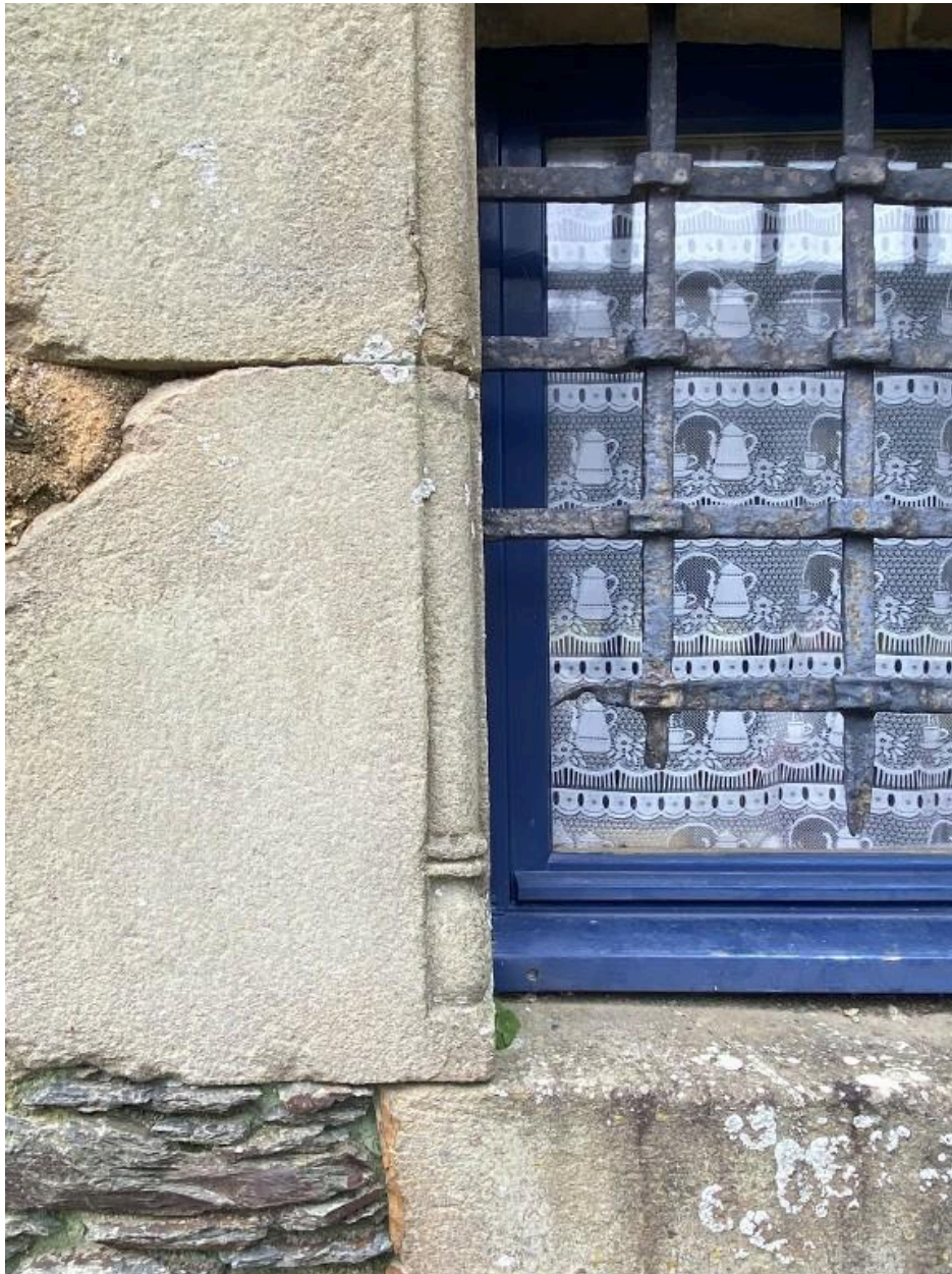
Aile nord, élévation sud, détail
