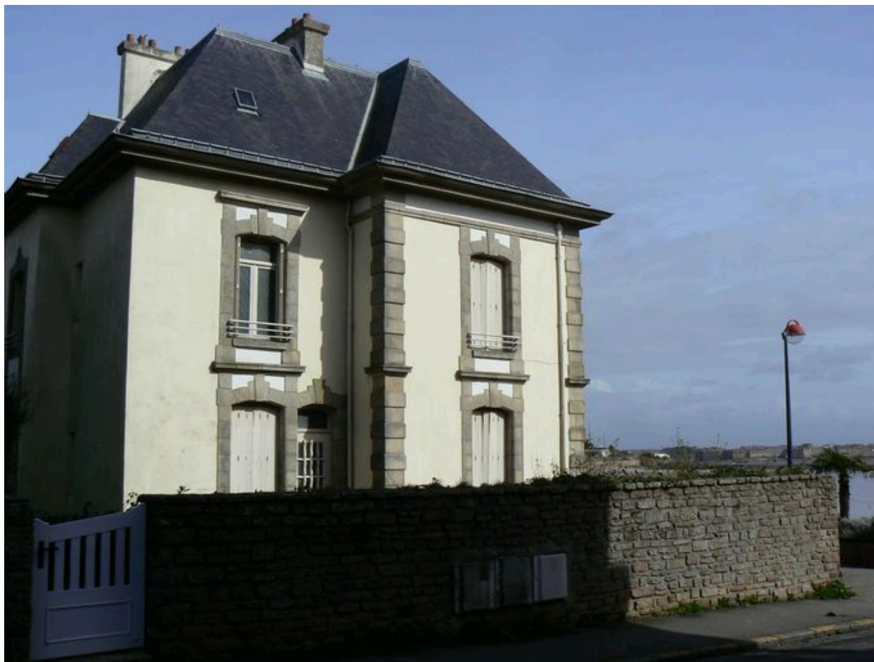
Vue latérale de la maison de villégiature du 14 rue du Beau Rivage
