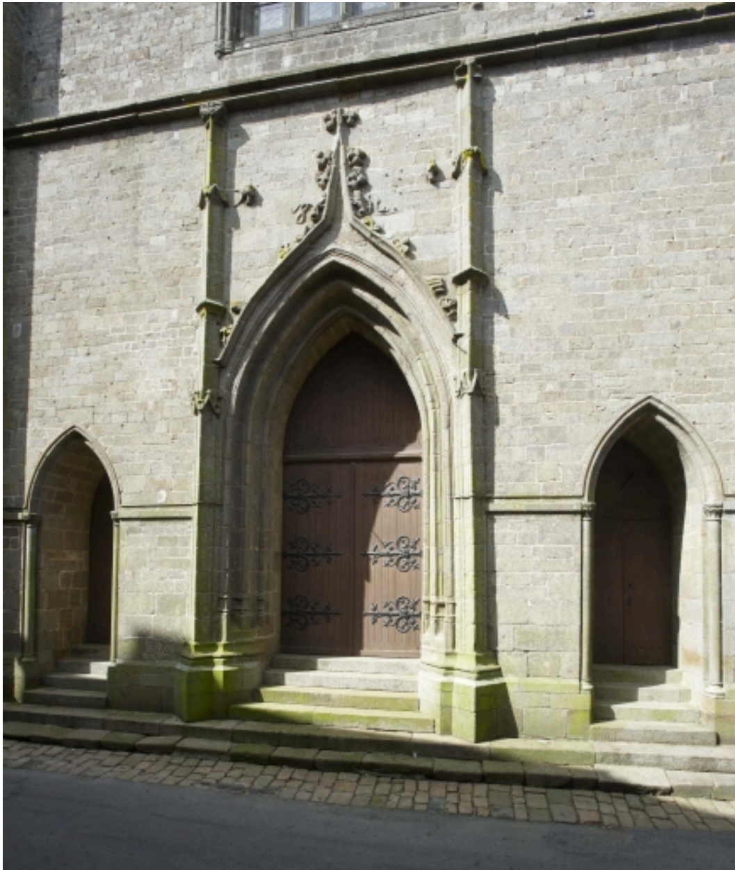
Eglise : porte principale
