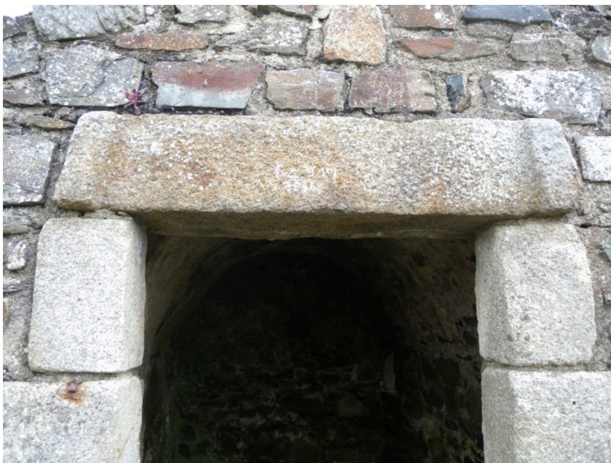
Vue des pierres d'encadrement de l'ouverture principale
