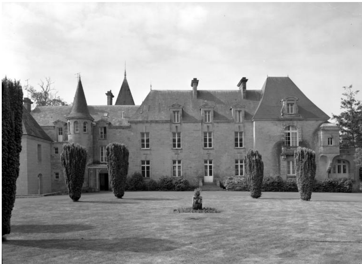
Château, logis, élévation nord.
