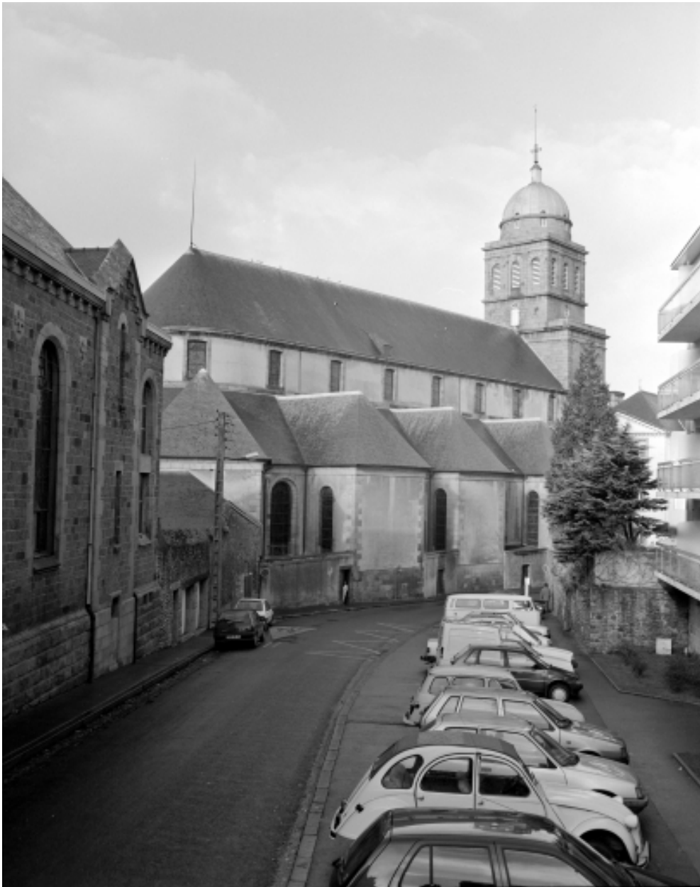
Elévation Sud-Ouest : vue générale
