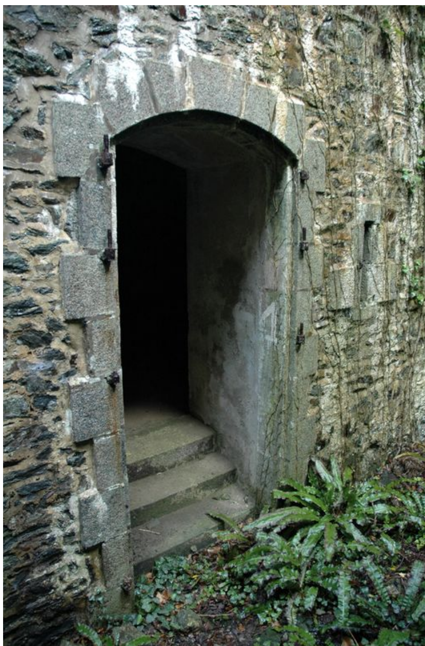
Vue de la caserne défensive Robert : entrée du magasin à poudre
