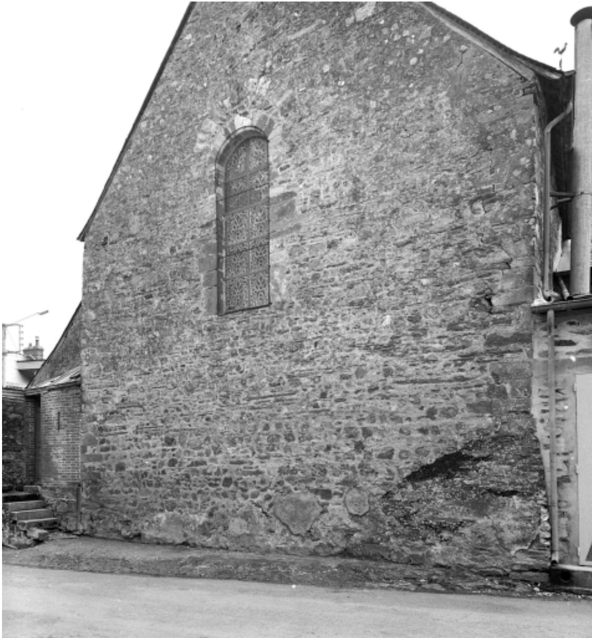
Transept, bras nord, fenêtre du pignon.
