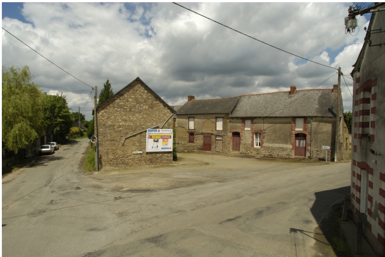
Vue générale sud
