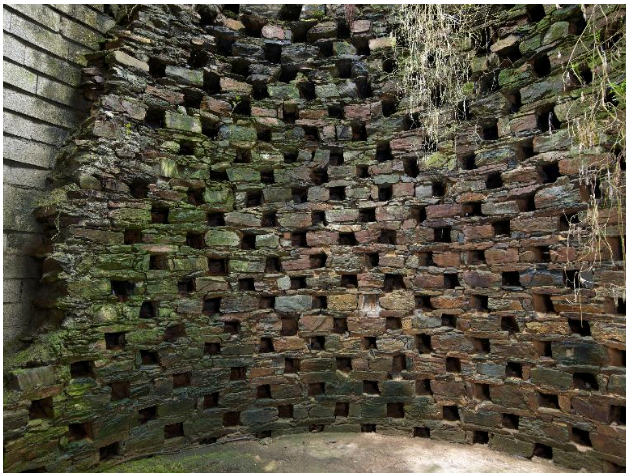
Colombier à l'ouest du château. Vue intérieure
