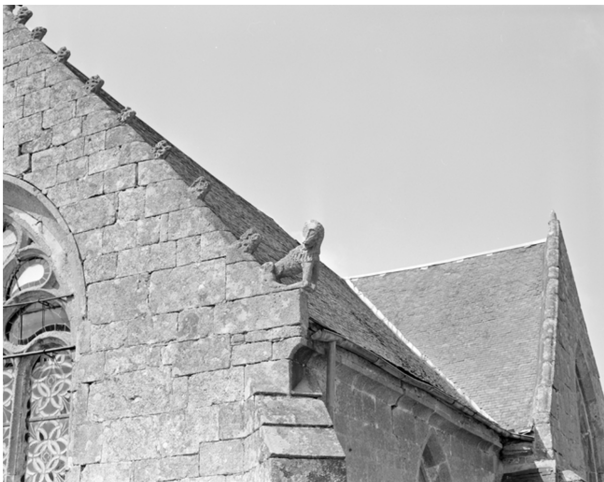
Transept sud : rampant
