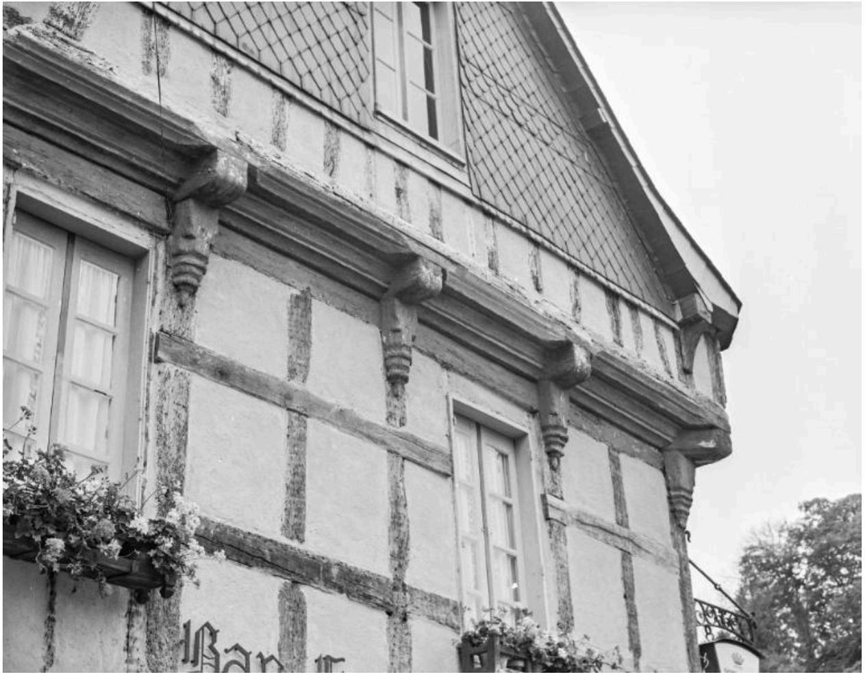
Elévation nord, partie supérieure, consoles et sablières moulurées
