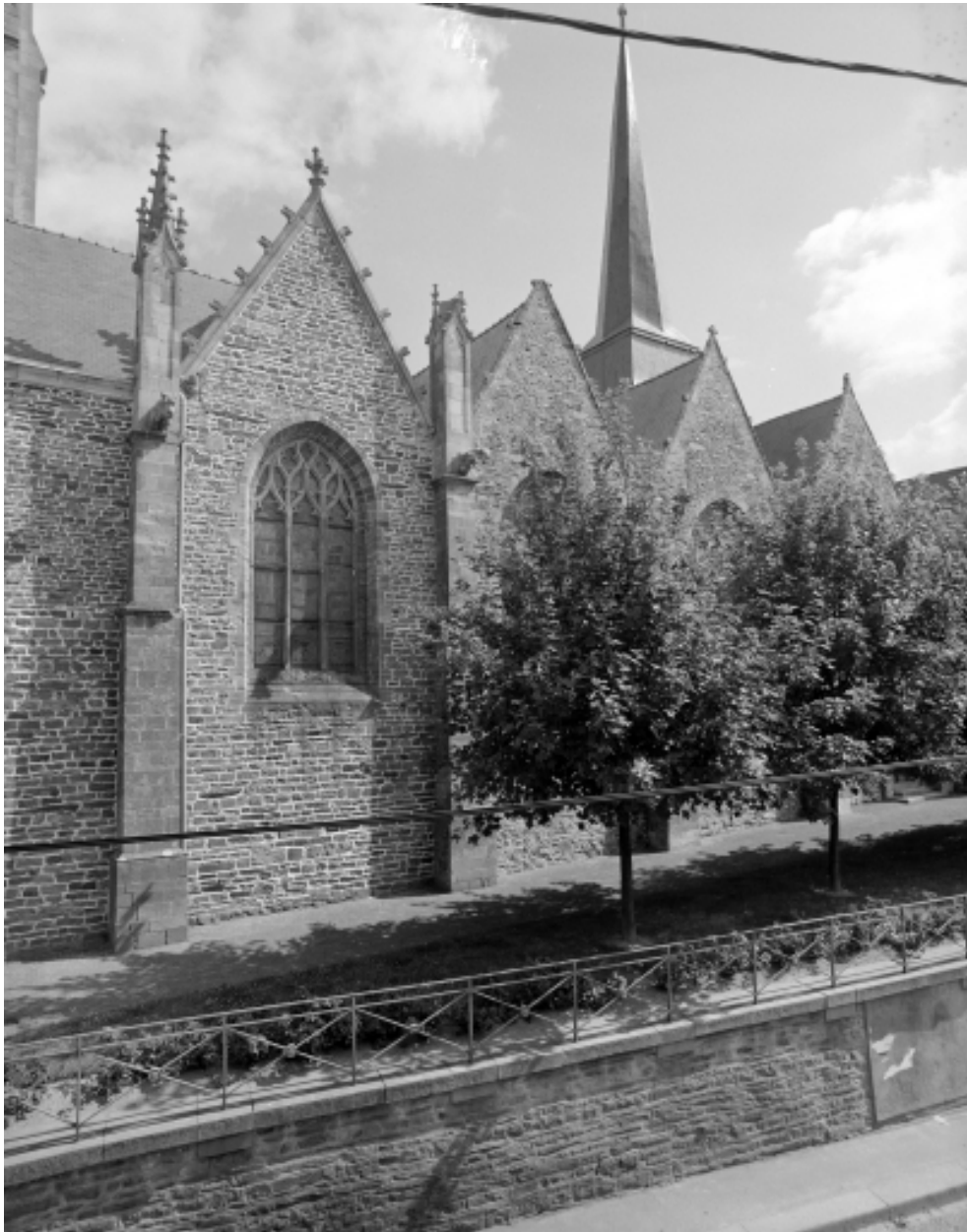
Elévation Nord : vue générale
