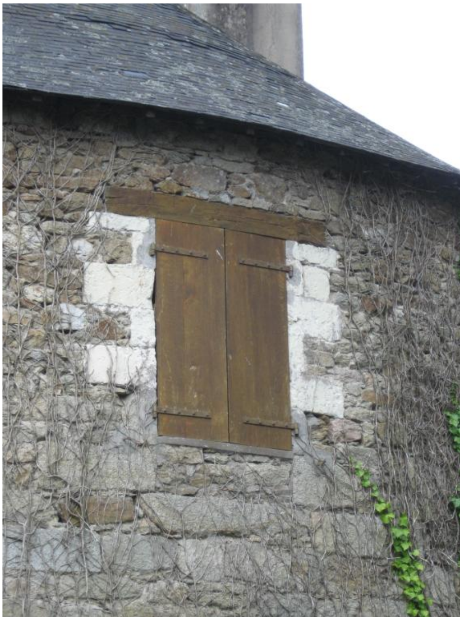
Fenêtre de l'étage, sur rue, montée dans un mur de moellons avec des pierres de tuffeau
