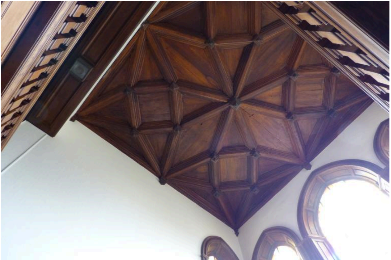
Plafond en fausse voûte du grand escalier
