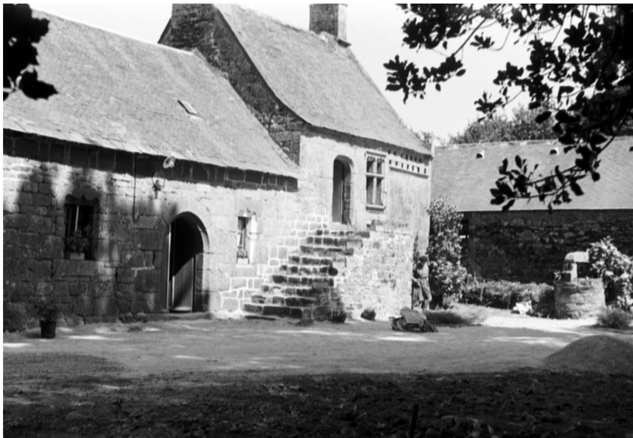
Maison et porcherie : vue générale.
